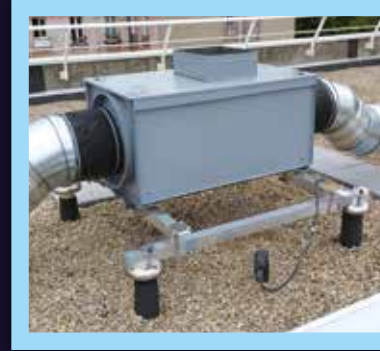
ÉQUIPEMENTS TECHNIQUES EN TOITURE
