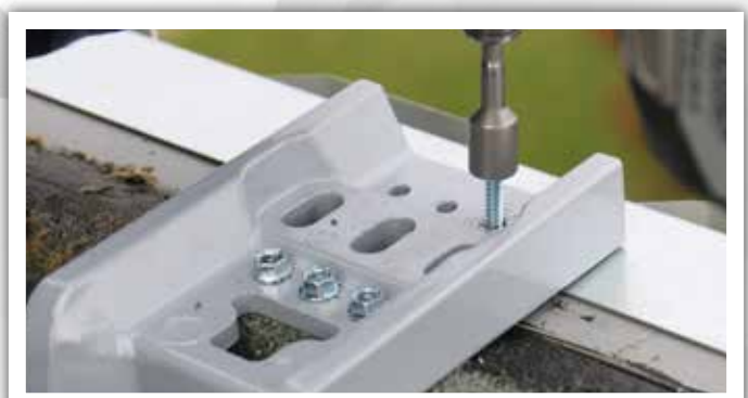
Fijación de la base Z sobre un murete metálico
