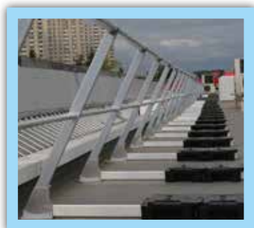
PROTECCIÓN COLECTIVA - BARANDILLAS
