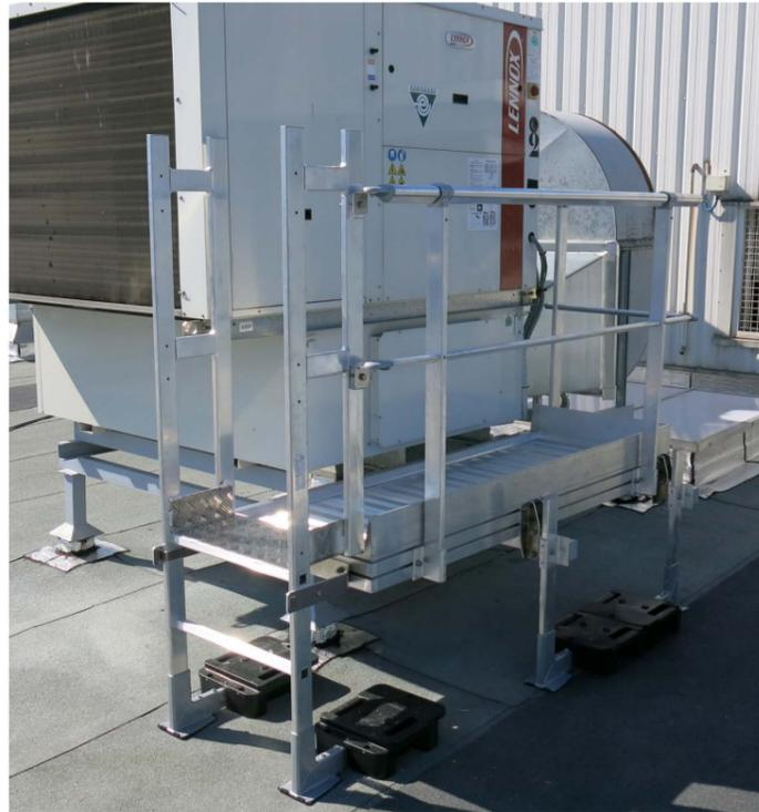
La passerelle permet la maintenance du matériel technique (ex : bloc de climatisation) en toute sécurité.
